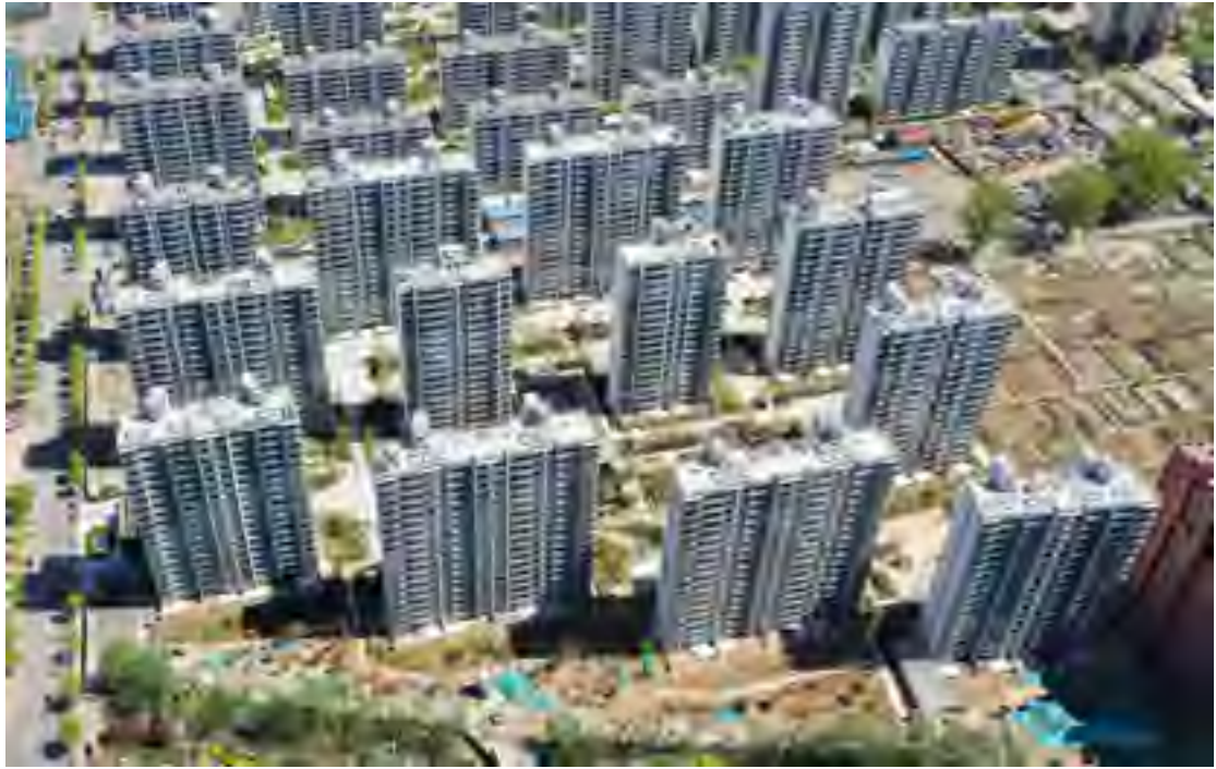
附图-4 项目区施工前后遥感影像（施工后）
